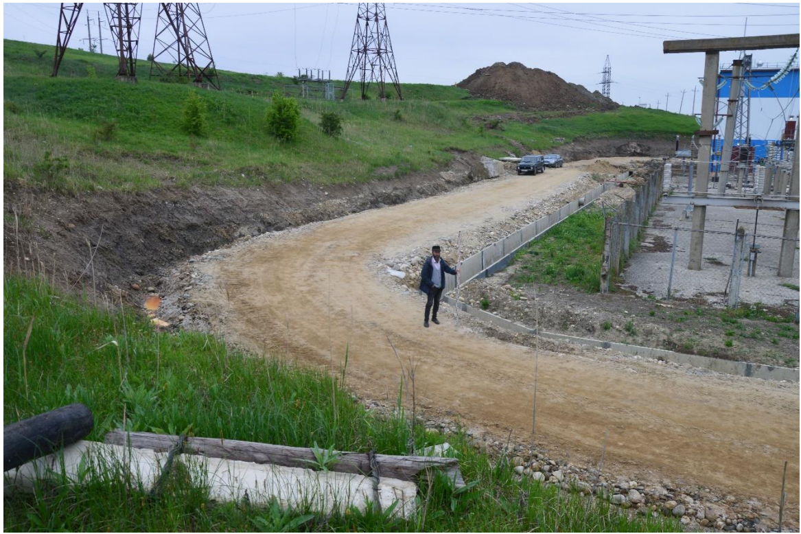
Рис. 8. Археологические исследования по титулу: «Каскад Кубанских ГЭС. ГЭС-2. Реконструкция ОРУ 110 кВ». Точка фотофиксации № 3. Вид на СЗ.
